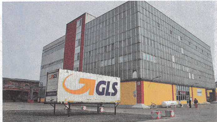
Dieses dreietagige Hallengebäude beherbergte einst u. a. das Fasslager der Brauerei und verfügt über einen Industrieaufzug.
